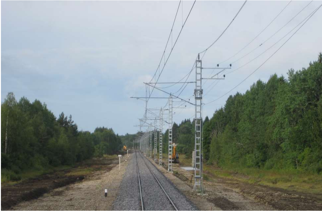
Joonis 2. Kontaktvõrgu riputamise tüüplahendus jaamavahel.
