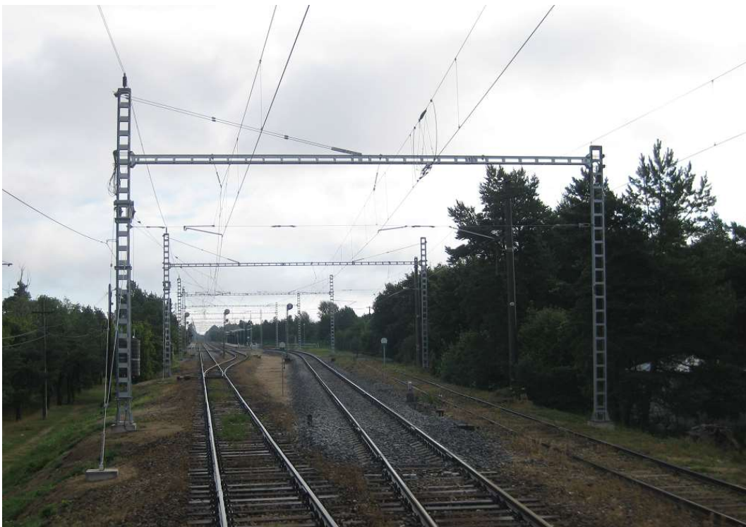
Joonis 1. Kontaktvõrgu riputamise tüüplahendus raudteejaamas.
